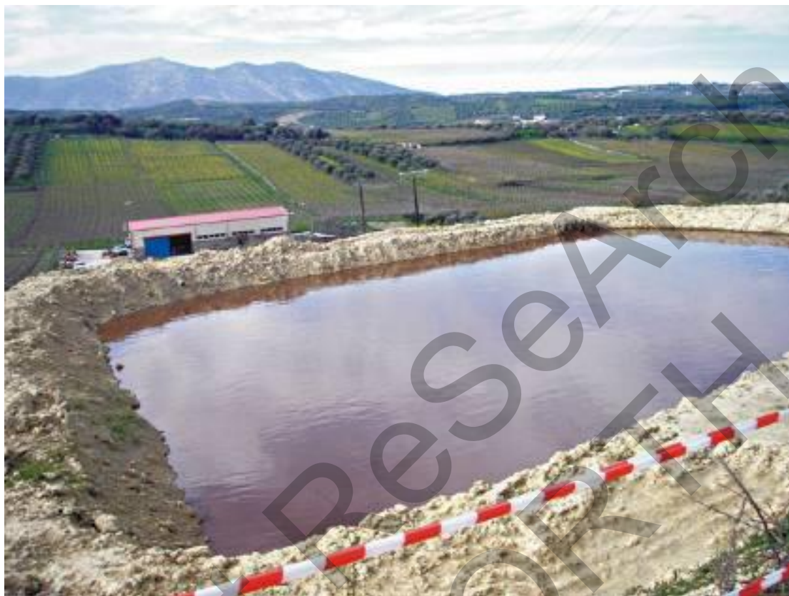
Εικόνα 2: Η μέθοδος των ανοικτών δεξαμενών εξάτμισης αποβλήτων ελαιουργείων επικράτησε λόγω του χαμηλού κόστους και της ευκολίας εφαρμογής για τις οικογενειακές επιχειρήσεις
